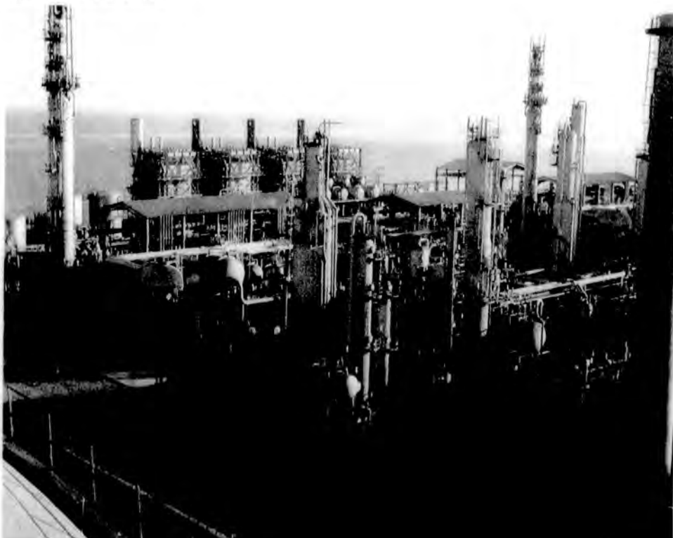
LNG Plant Das Island
