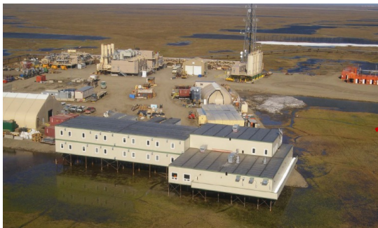
Oooguruk Tie-in Pad (OTP)
